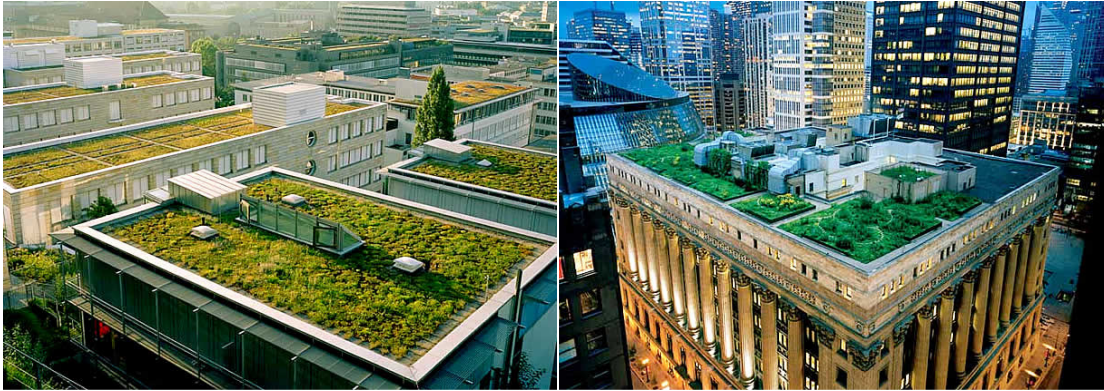
Fig. 26: Telhados verdes: à esquerda prédios em Stuttgart; à direita Prefeitura de Chicago
