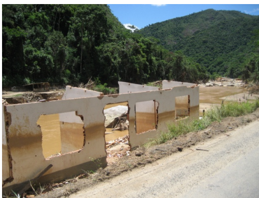
Fig. 8: Casa à beira do Rio Preto e às margens da estrada, destruída pela enchente em janeiro de 2011
