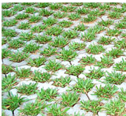
Fig. 27: Pavimento com drenagem
