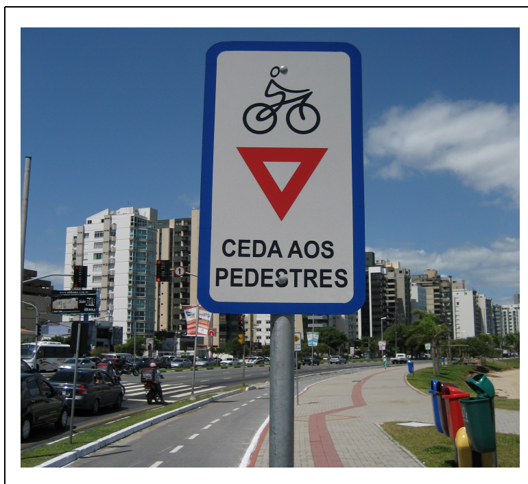
Figura 30: Sinalização com diagramação e cores em desacordo com o CONTRAN. Fonte: Da autora (2012).
