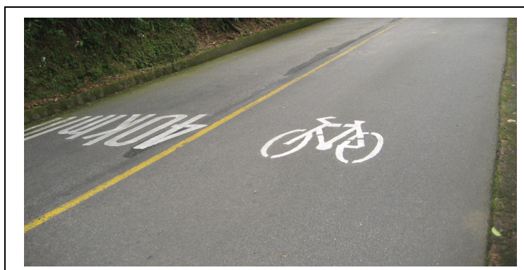
Figura 20: Sinalização horizontal de via de uso exclusivo de bicicletas - SIC aplicada na Estrada da Vista Chinesa. Fonte: Da autora (2011).
