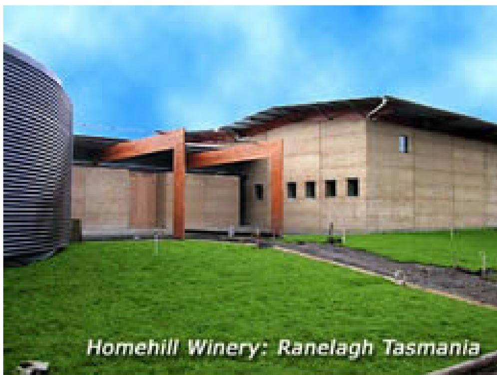
**Foto 3.1** – Arquitetura com terra (utilização da técnica de terra crua em interface com outras técnicas construtivas de diferentes materiais como o aço e a madeira). Ranelagh – Tasmania / Austrália.
