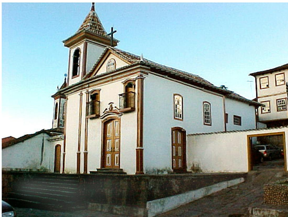
**Foto 2.12** – Igreja construída com técnica construtiva de terra crua. Minas Gerais / Brasil.
