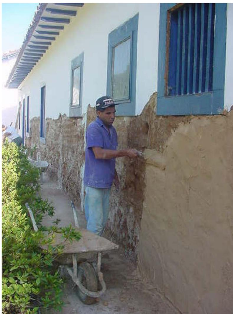
**Foto 3.7** – Aplicação de argamassa de cal hidráulica na parede para restauro de emboço.
