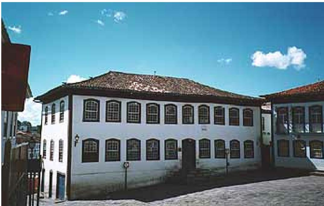
**Foto 2.11** – Edificação construída com a utilização de técnica construtiva de terra crua. Minas Gerais / Brasil.
