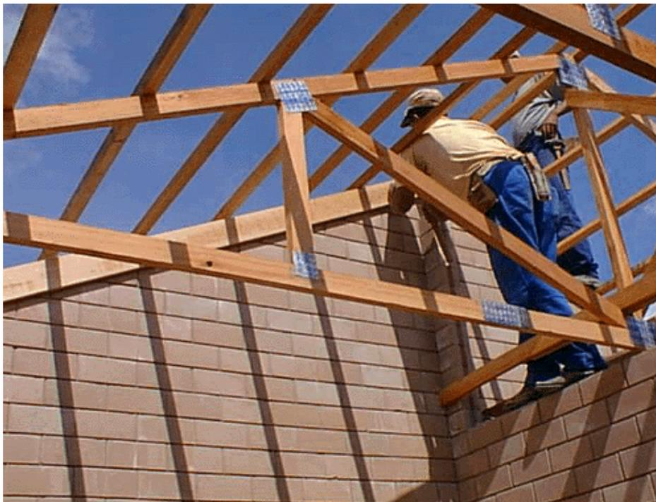
**Foto 6.4** – Execução da estrutura da cobertura.
