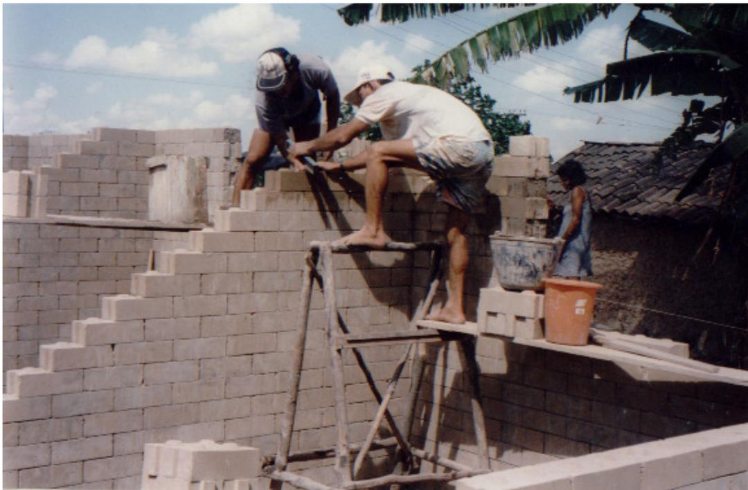
**Foto 6.8** – Execução da alvenaria. Projeto de erradicação das casas de taipa da favela
