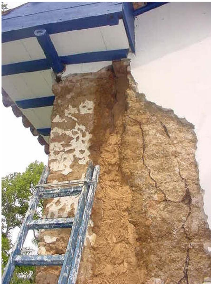
**Foto 3.6** – Patologia decorrente da ação erosiva provocada pela água de chuva incidente na parede, ocasionando o desprendimento e a perda de material.
