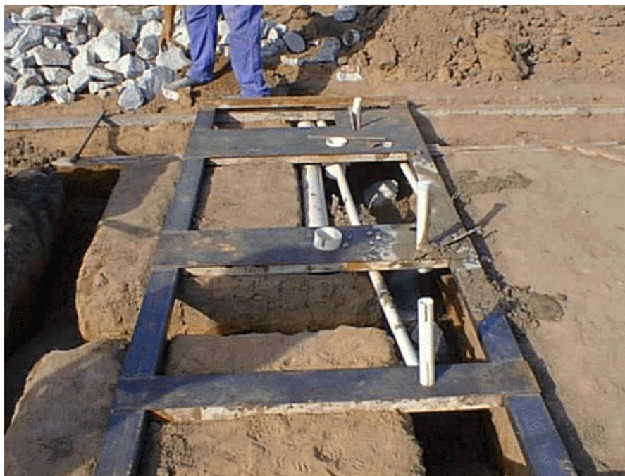
**Foto 6.1** – Montagem de kit de instalação de esgoto com o auxílio de um gabarito.
