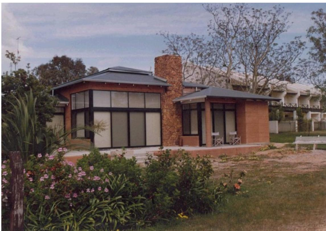
**Foto 7.1** – Casa construída utilizando uma combinação técnica e estética de diferentes materiais: paredes de terra estabilizada, pedra e vidro – Mandurah / Austrália.
