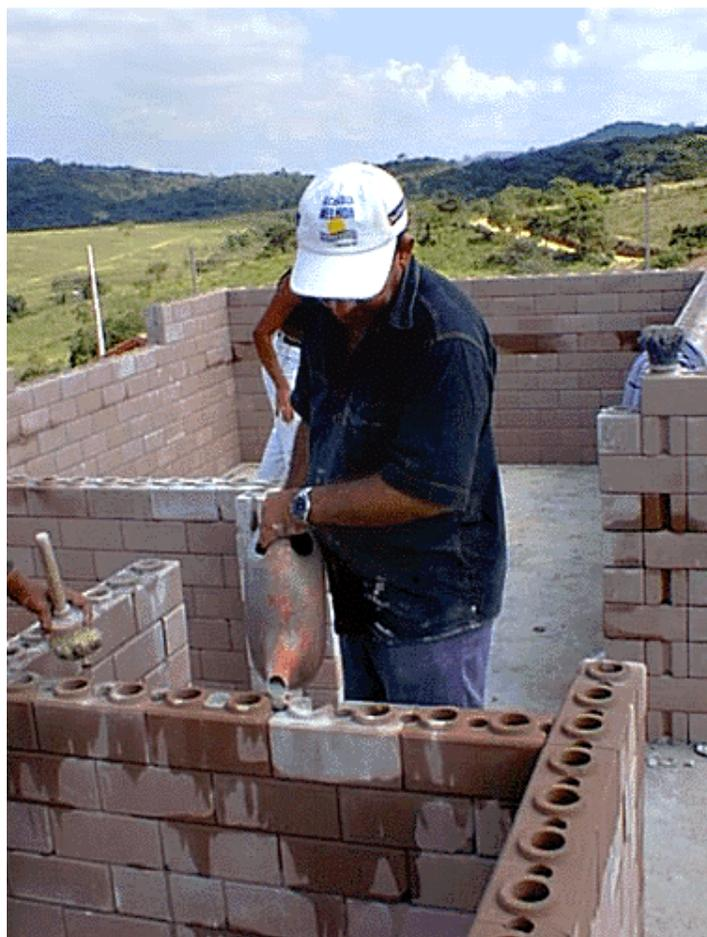
**Foto 6.10** – Execução da alvenaria (preenchimento dos furos menores) do tijolo com argamassa fluída
