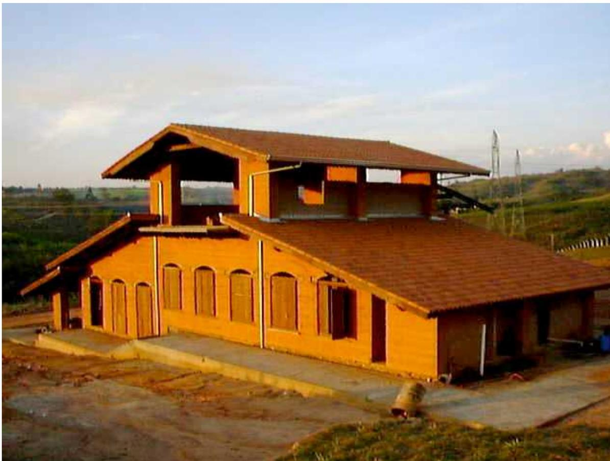
**Foto 4.1** – Casa construída utilizando a técnica construtiva de taipa de pilão. Campinas – São Paulo / Brasil.
